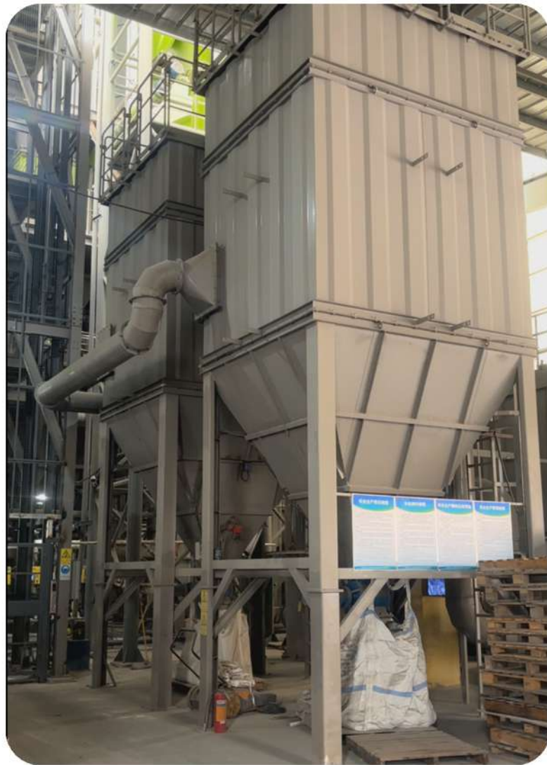
Silos de Almacenamiento:
